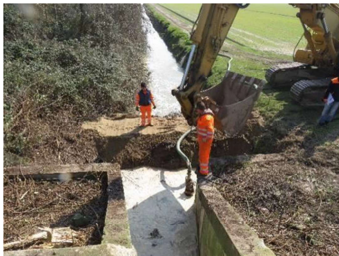
Figura 27. Fase di sostituzione di una chiavica
